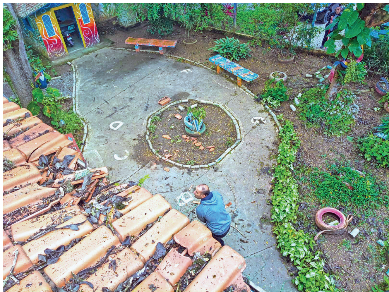
Intervenções nas escolas da rede municipal garantem condições adequadas de funcionamento
