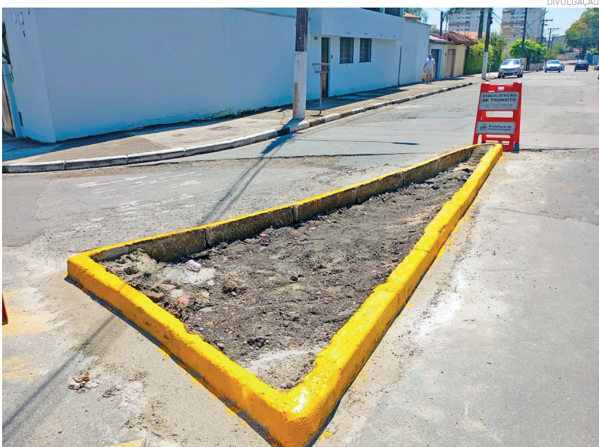
Um minitrevo foi construído para organizar a circulação de veículos
