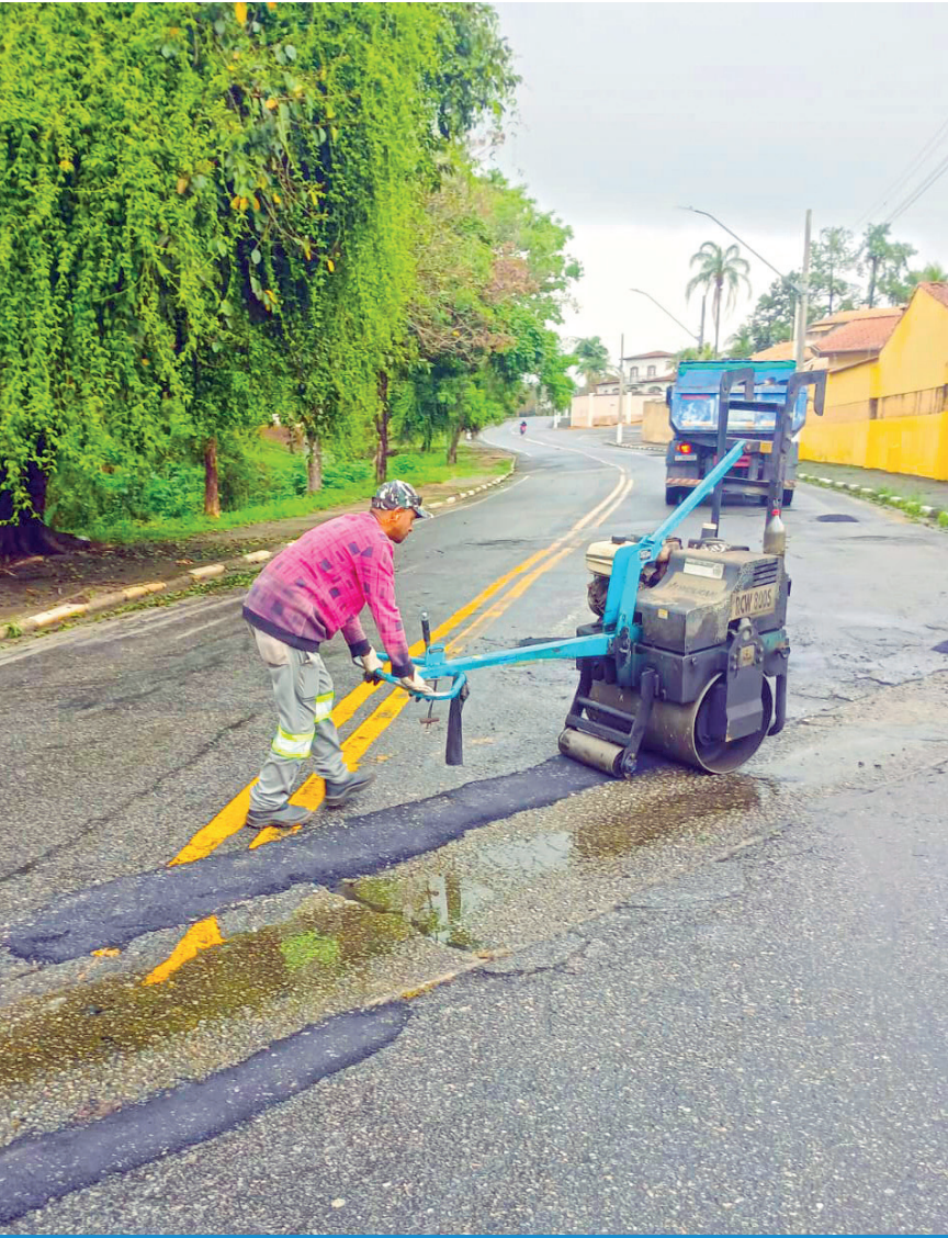
Equipe da Prefeitura repara falhas no asfalto decorrentes das chuvas
