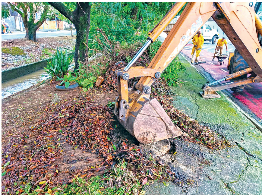
Limpeza à margem do córrego previne a ocorrência de alagamentos
