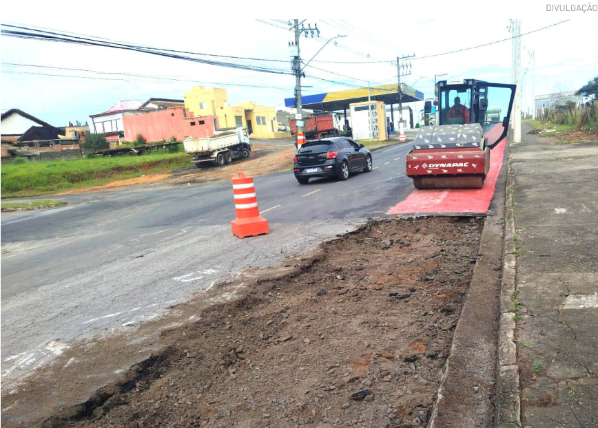
O programa Asfalto Novo vem levando melhorias para diversos bairros de Pindamonhangaba
