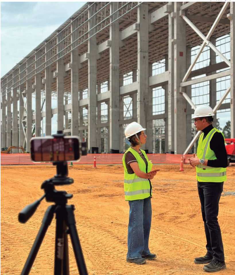
A unidade da Hitachi Energy segue em obras com previsão para funcionamento em 2027
