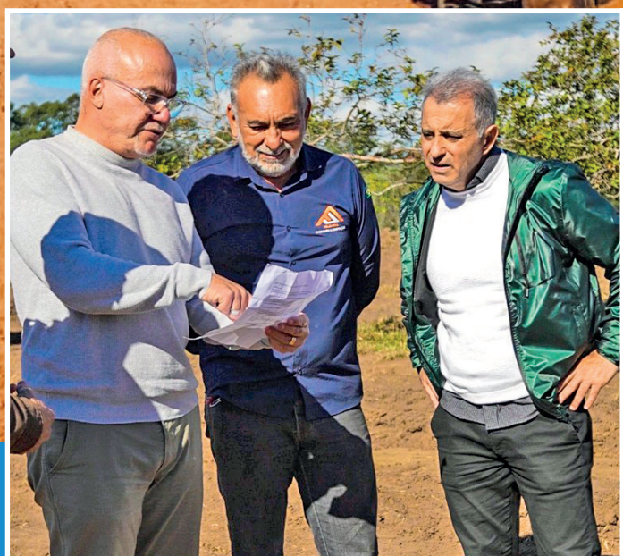
Após a reunião no gabinete, o prefeito visitou o canteiro de obras, instalado na avenida José Adhemar César Ribeiro, próximo ao CE Zito, e acompanhou o andamento dos trabalhos de terraplenagem
