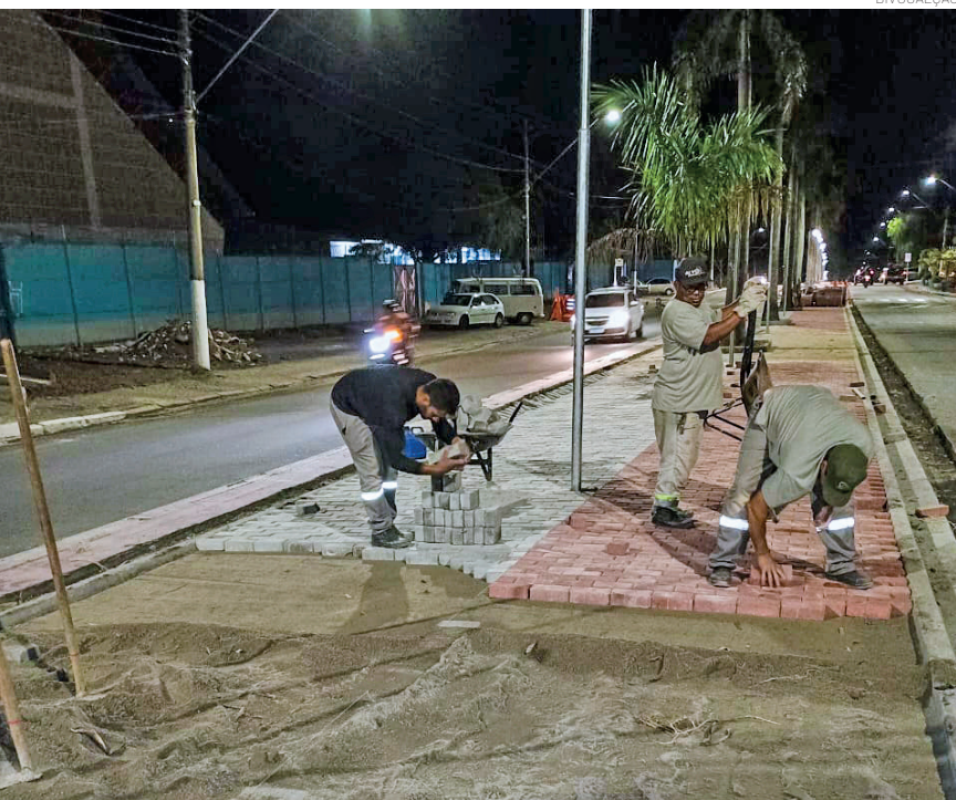
Canteiro da avenida Theodorico Cavalcante recebe assentamento de piso
