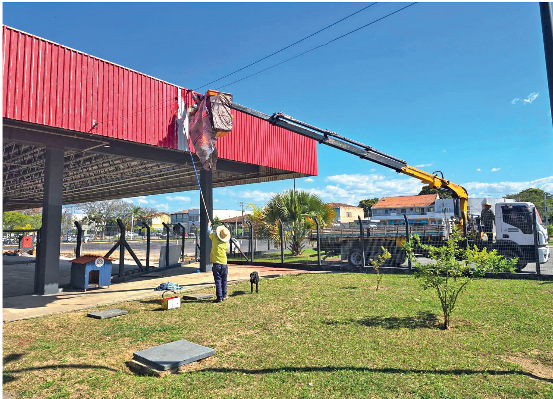
Adaptação do prédio da antiga rodoviária inclui uma ampla reestruturação do imóvel, com a construção de novos espaços e remodelação dos existentes
