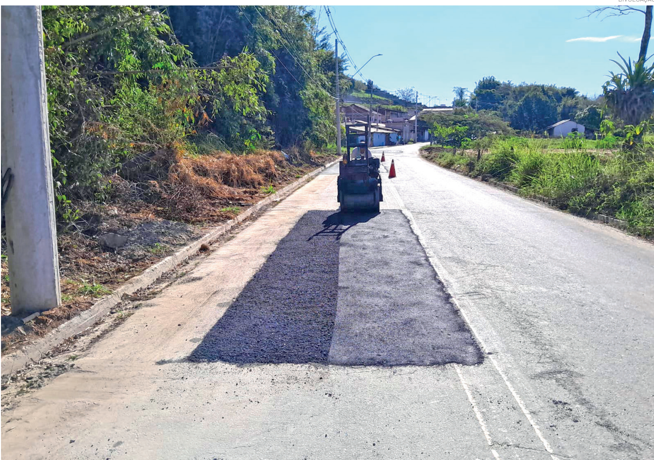
Trechos das estradas rurais que apresentam desgaste estão recebendo recapeamento asfáltico
