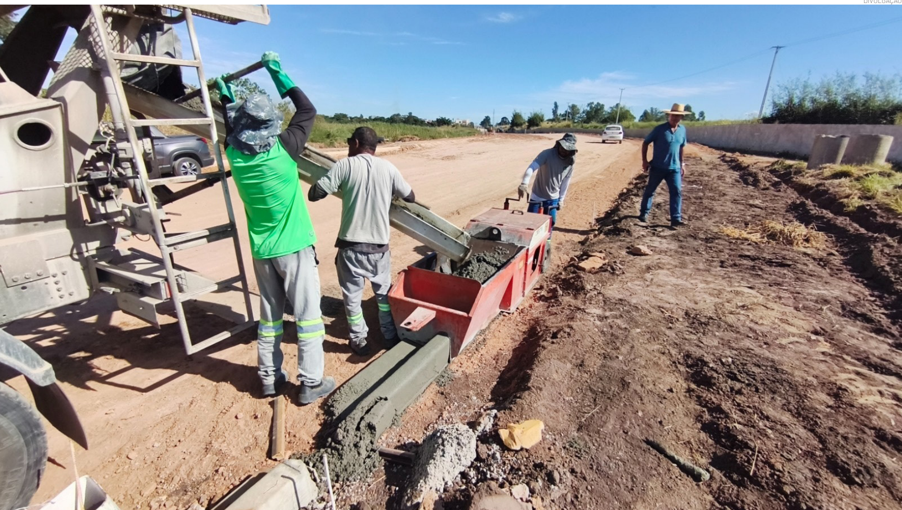
Equipes de trabalho executam serviços de terraplanagem, construção de guias e sarjetas e preparação da base da via para o início da pavimentação
