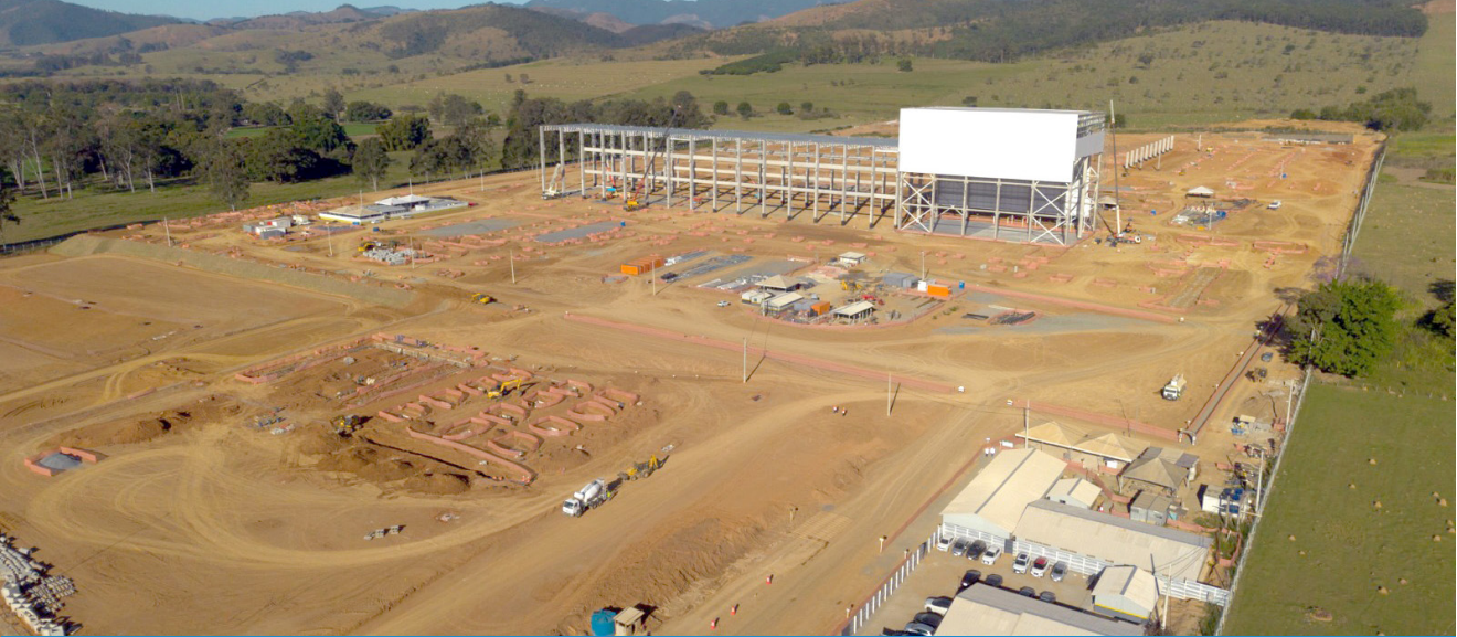
As primeiras instalações reforçam o compromisso da empresa com a construção de uma planta moderna e eficiente
