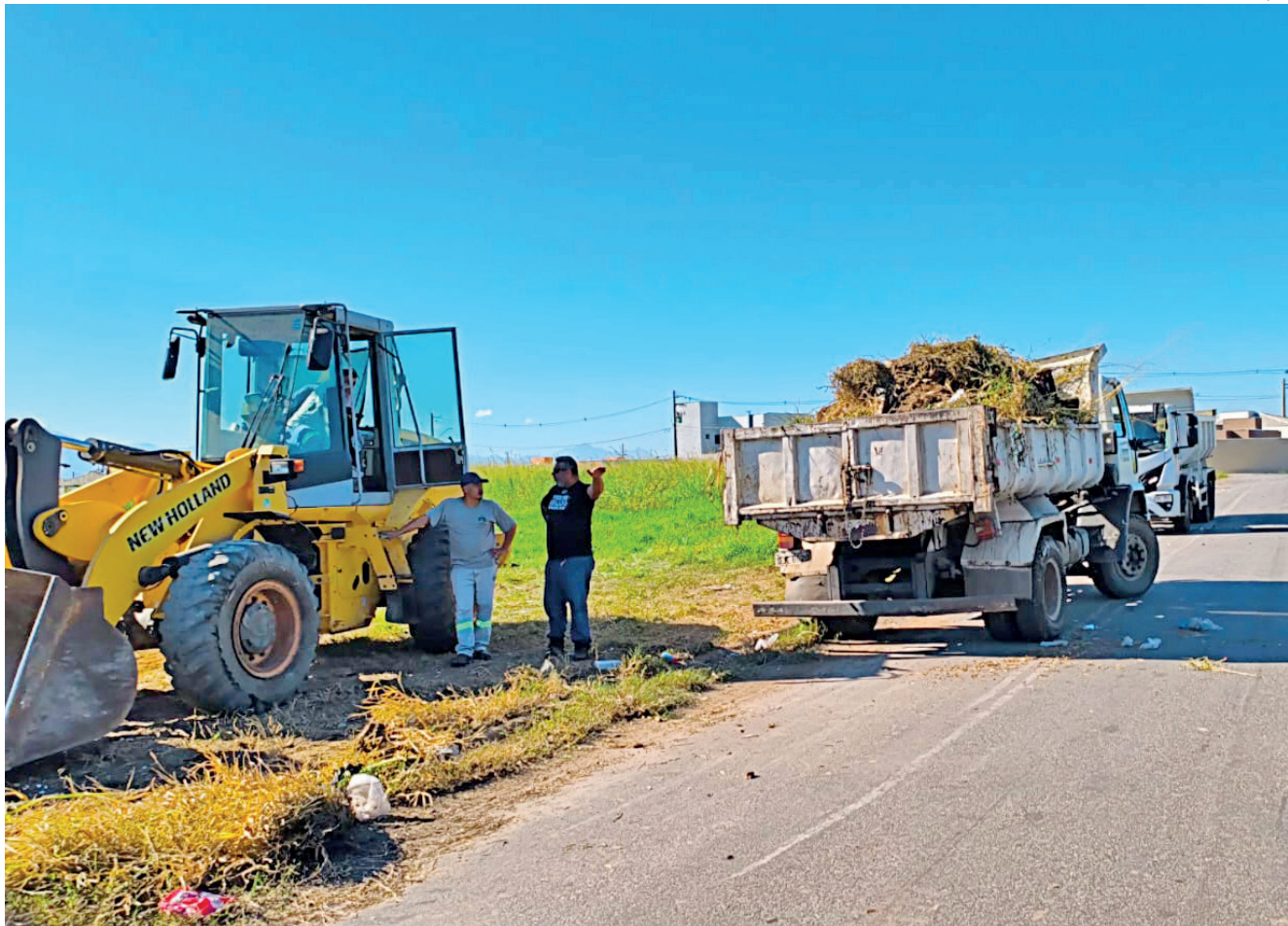
Serviços concentraram-se no Portal dos Eucaliptos, com capina, roçada, limpeza geral e retirada de vegetação
