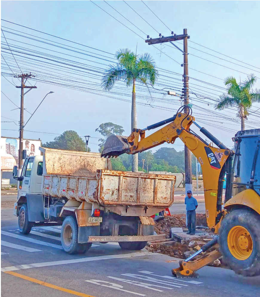
Trabalho de retirada de descartes removeu entulhos, móveis e resíduos
