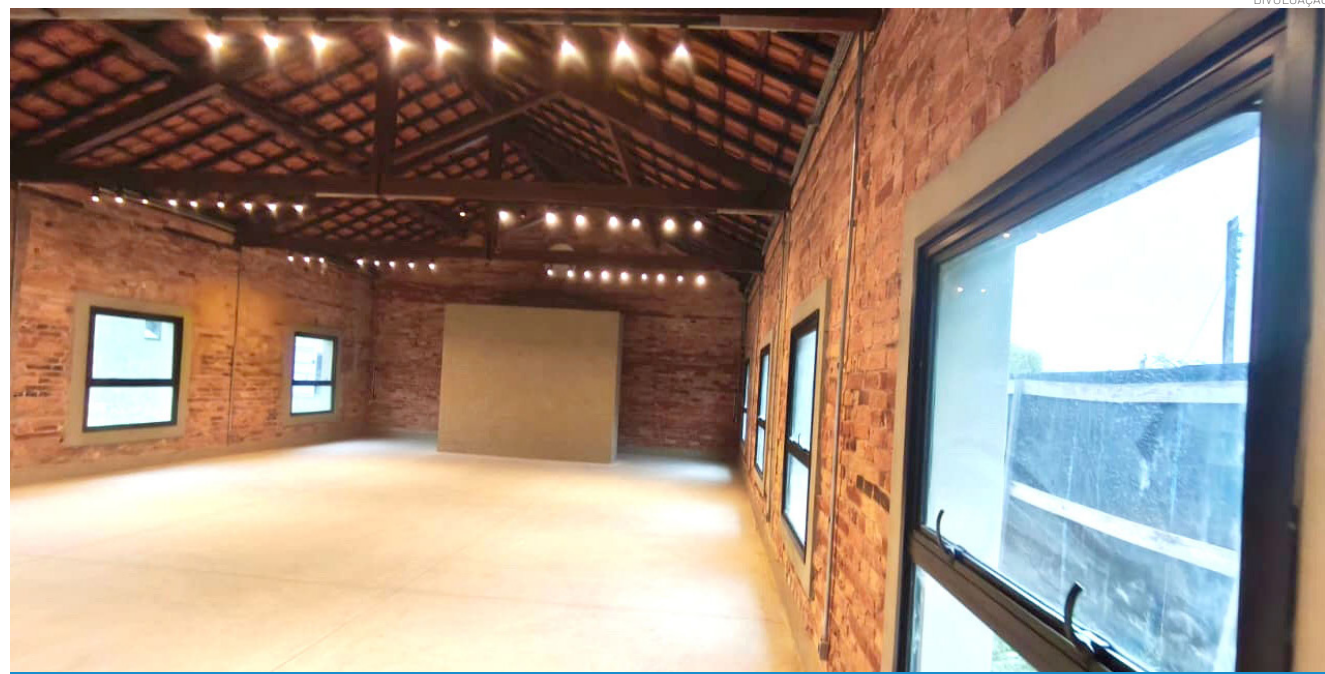
A obra integra o processo de revitalização de prédios e estruturas do Parque da Cidade
