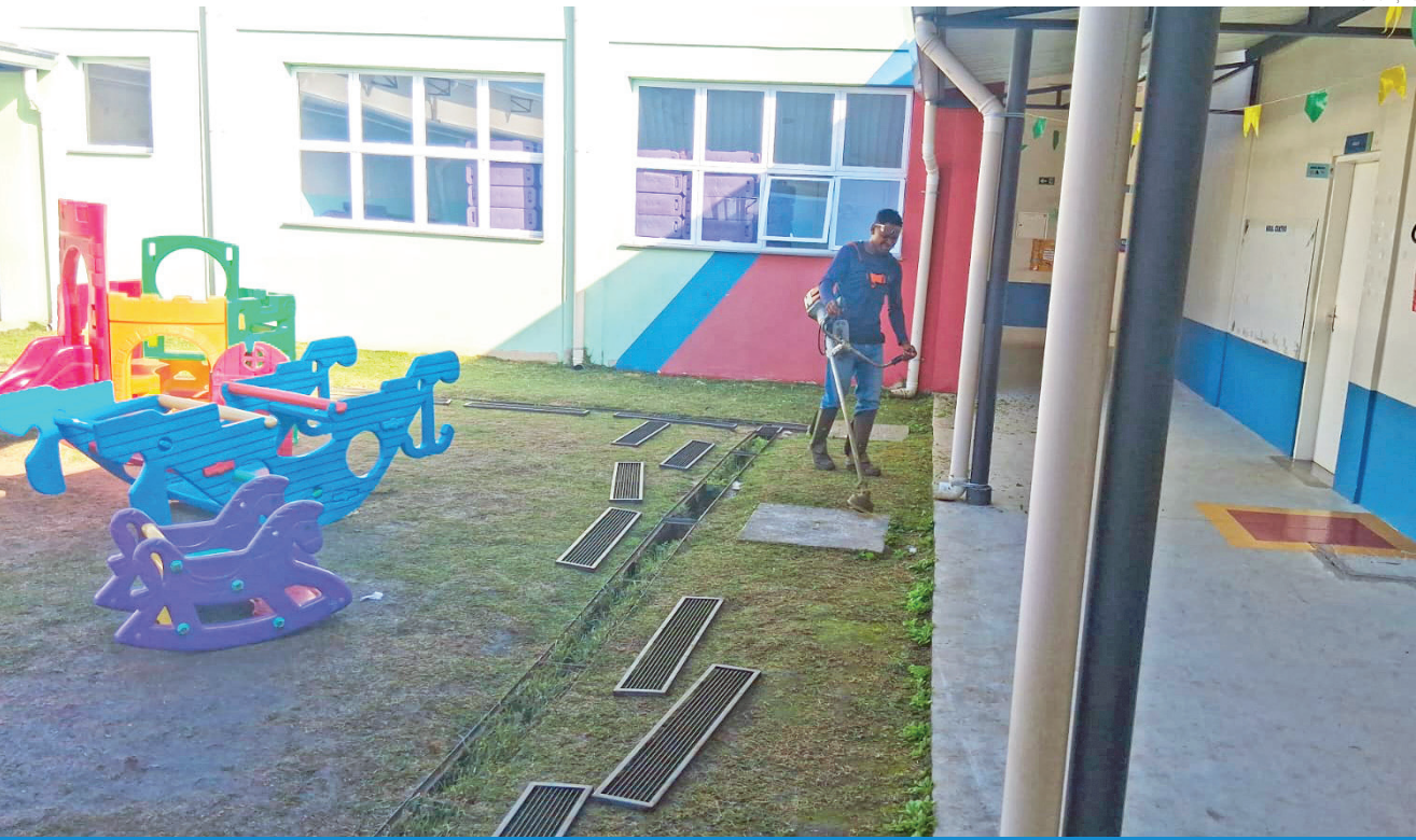
Pintura de salas e áreas externas, corte de grama, manutenção em telhados, reparos em portas e azulejos, conserto de concertina, instalação de alambrados, manutenção de ventiladores, melhorias em acessibilidade e pequenos reparos estruturais são alguns dos serviços executados
