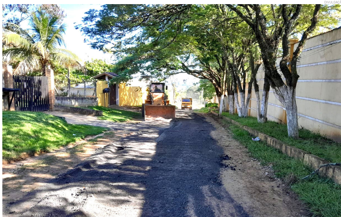
As melhorias vem acontecendo em mais de 700 km de estradas rurais em todo o município
