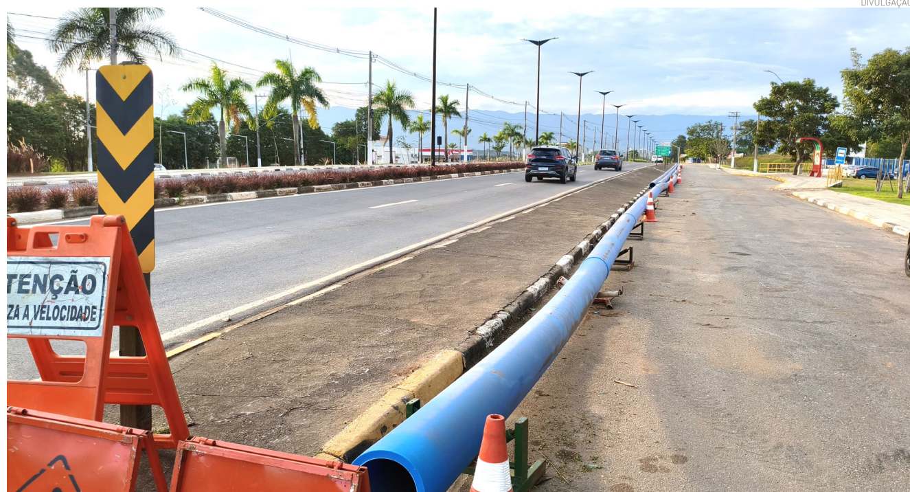
A obra vai atender a crescente demanda por infraestrutura, principalmente com a chegada de indústrias
