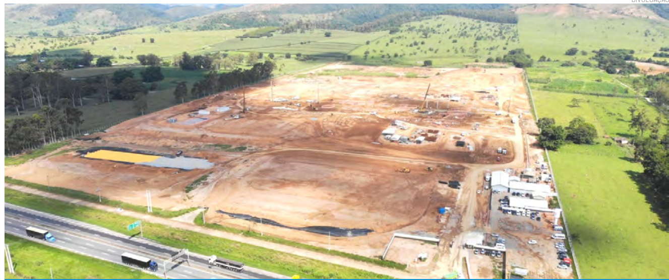
As obras estão completando oito meses de atividades, com evolução intensa no ritmo de trabalho e total apoio do poder público local
