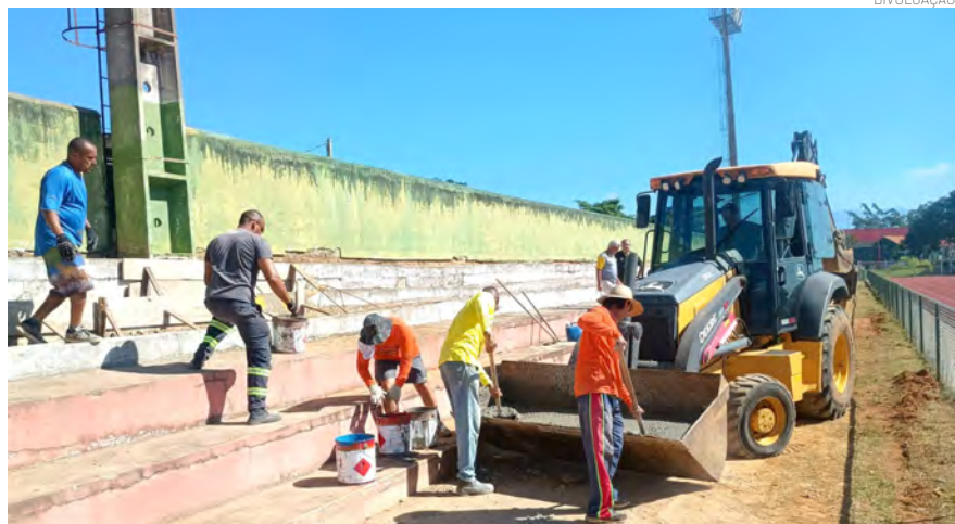
Após esta etapa, ainda serão executadas outras melhorias para que a nova pista possa ser inaugurada
