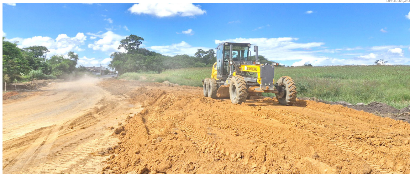
Nessa fase, os serviços estão concentrados no aterramento e no alteamento do terreno
