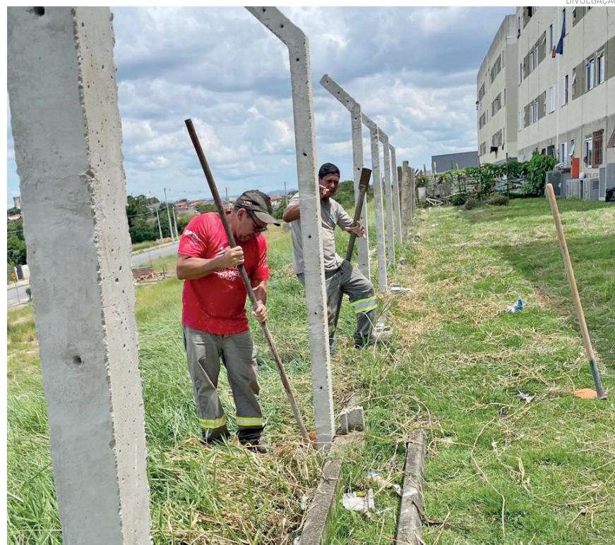
Equipe da Prefeitura procede a instalação de mourões do alambrado
