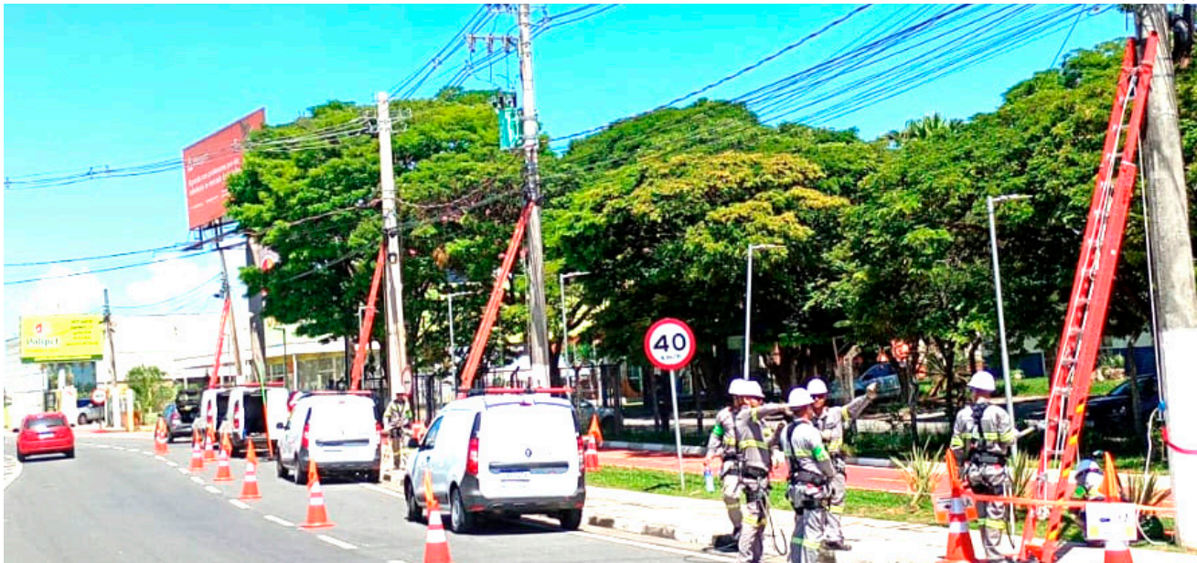
Ação tem como objetivo a remoção de cabos de internet e telefonia excessivos e irregulares da cidade
