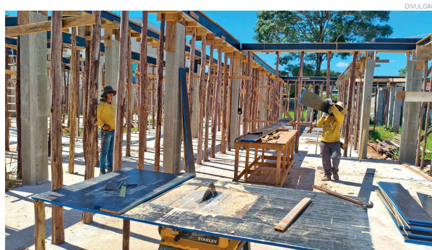
Obra da UBS Santana já exhibe os pilares de sustentação
