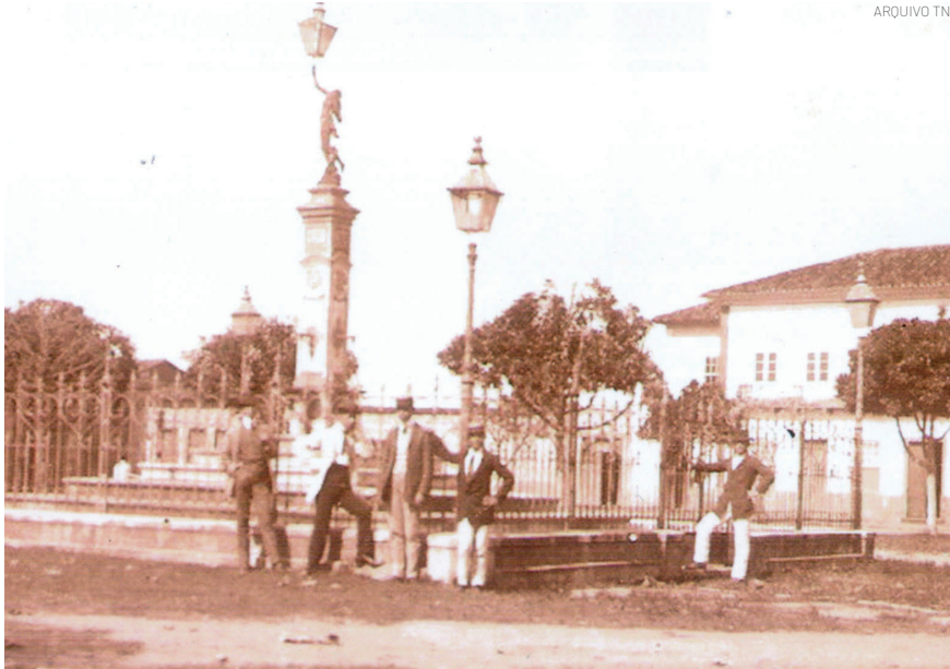
Chafariz que marcou o 1º serviço de água encanada do município, manancial do córrego do Felipe, no Trabiçu (serra da Mantiqueira), desde 1959 se encontra na Praça Dr. Emilio Ribas
