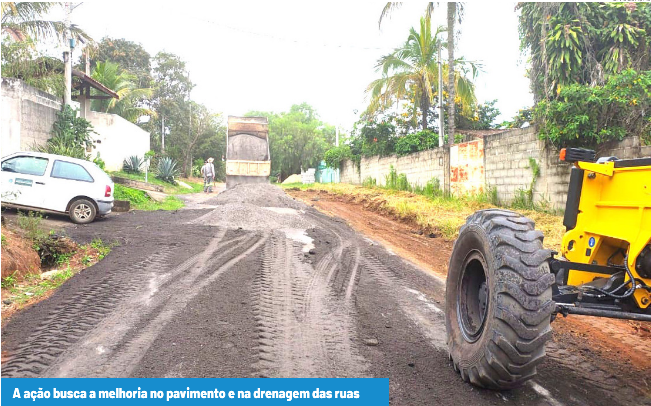
A ação busca a melhoria no pavimento e na drenagem das ruas
