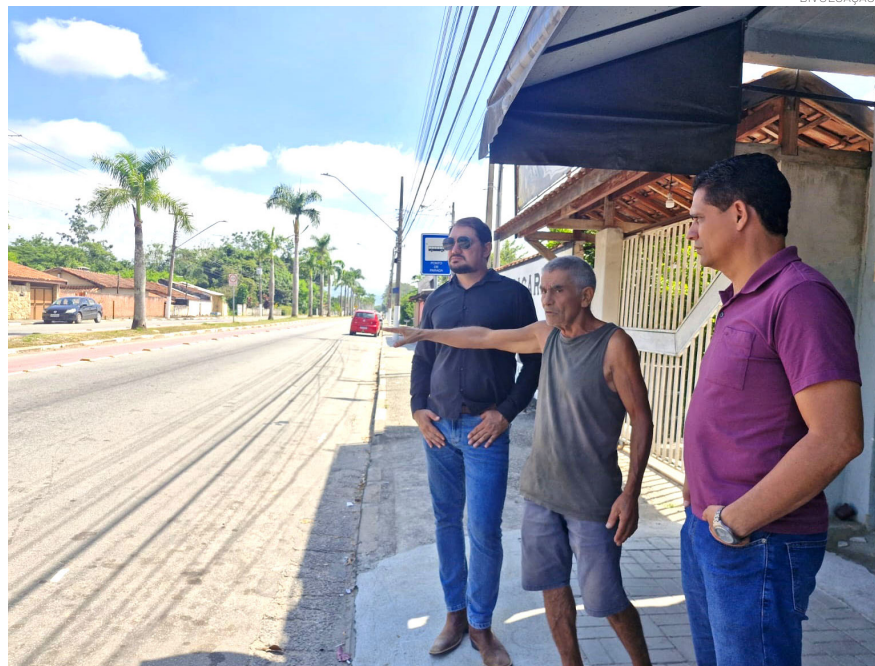
Entre os serviços previstos estão a substituição de guias e sarjetas, e pavimentação com piso intertravado
