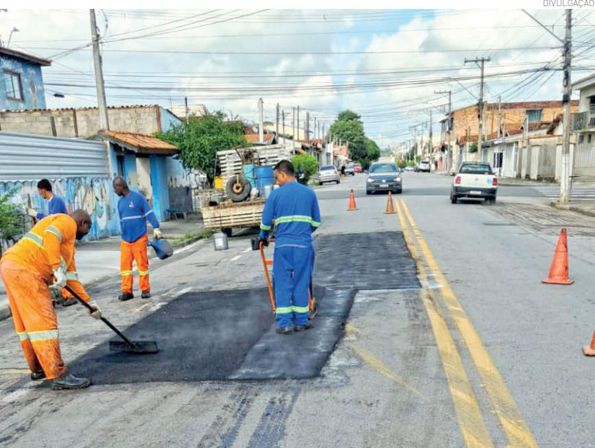
Equipe da Prefeitura efetuando recomposição de pavimento asfáltico
