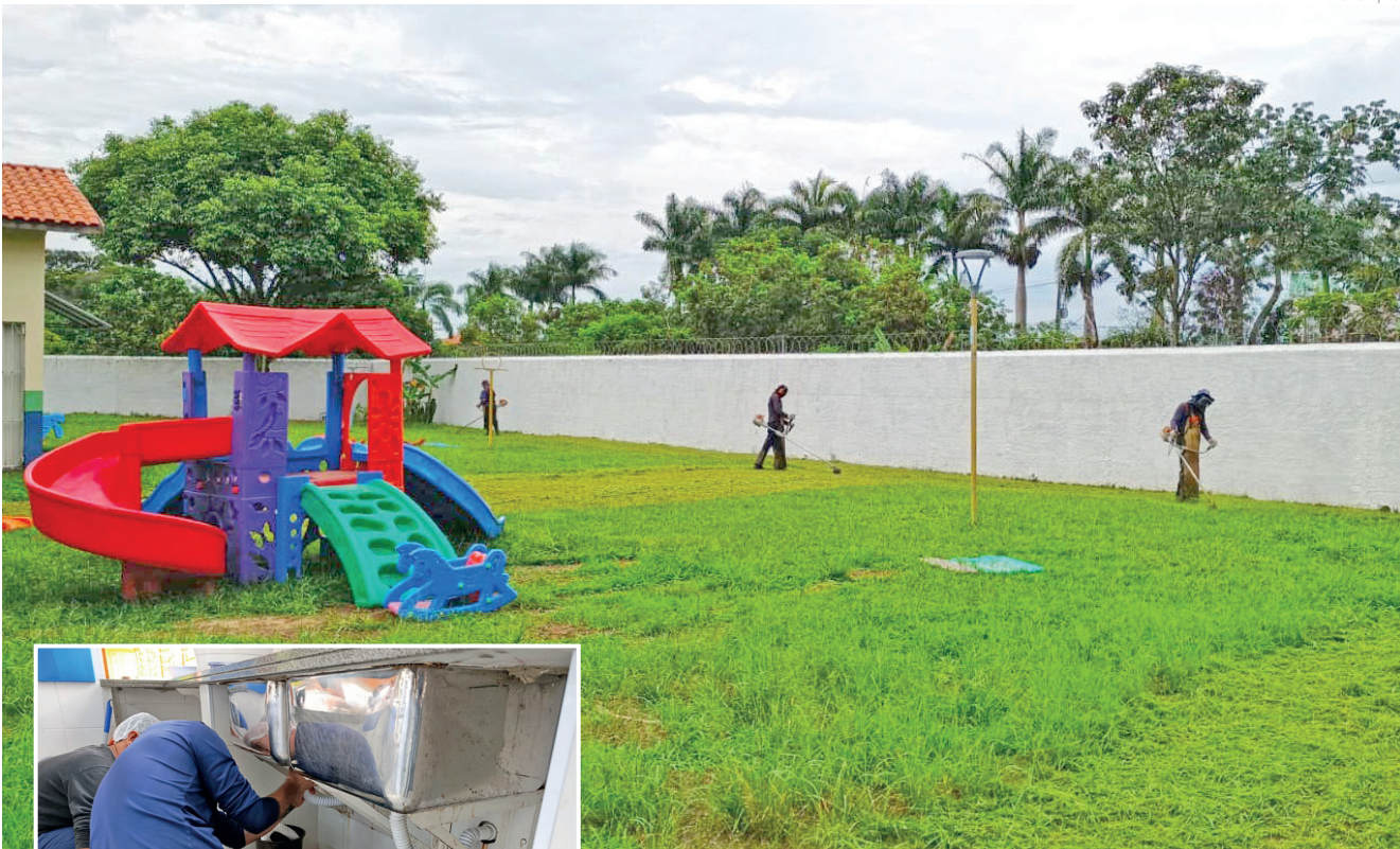
As ações incluem desde intervenções simples, como troca de filtros de água e serviços de jardinagem até melhorias mais estruturais, como substituição de ventiladores
