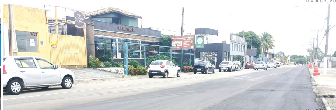
Acima, foto do serviço de recapeamento concluído na avenida do Socorro. Prefeito Ricardo Piorino visita as obras da nova rede da Sabesp no local
