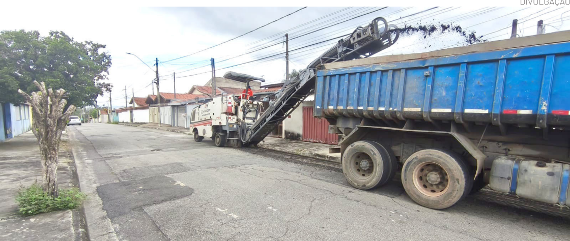
Foto da fresagem no Jardim Imperial, preparando a área para o recapeamento
