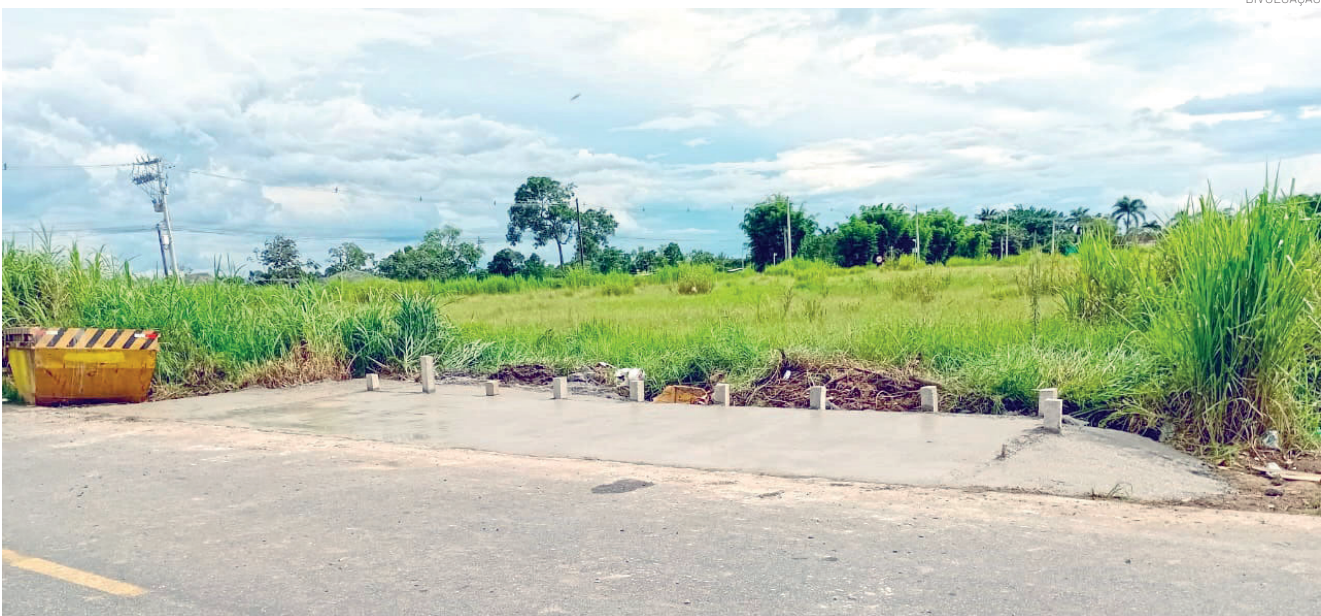
Foi construída uma base de concreto com calçada para garantir o encaixe adequado da caçamba
