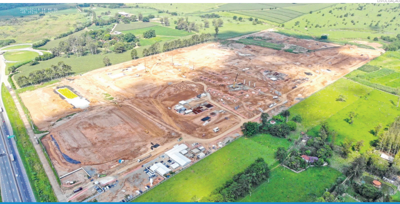
A terraplanagem da área destinada ao bloco principal da futura planta industrial está concluída
