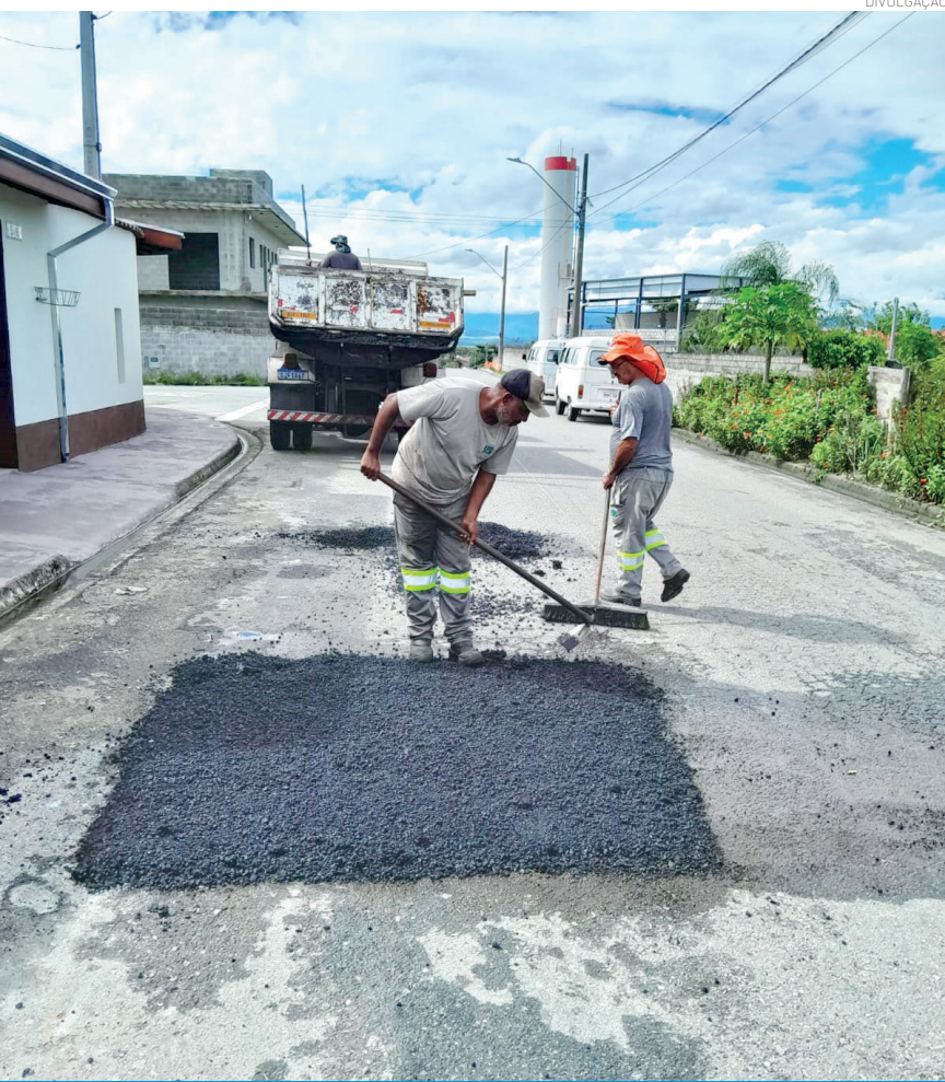
As intervenções corrigem pontos de desgaste no asfalto
