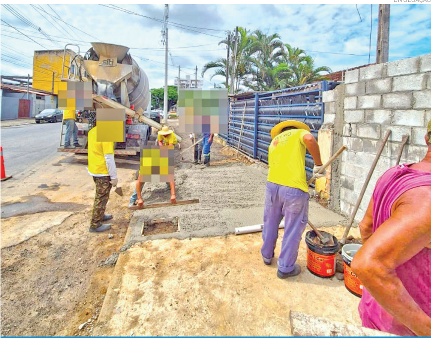
Concretagem em calçada a rua Voluntário Vitoriano Borges
