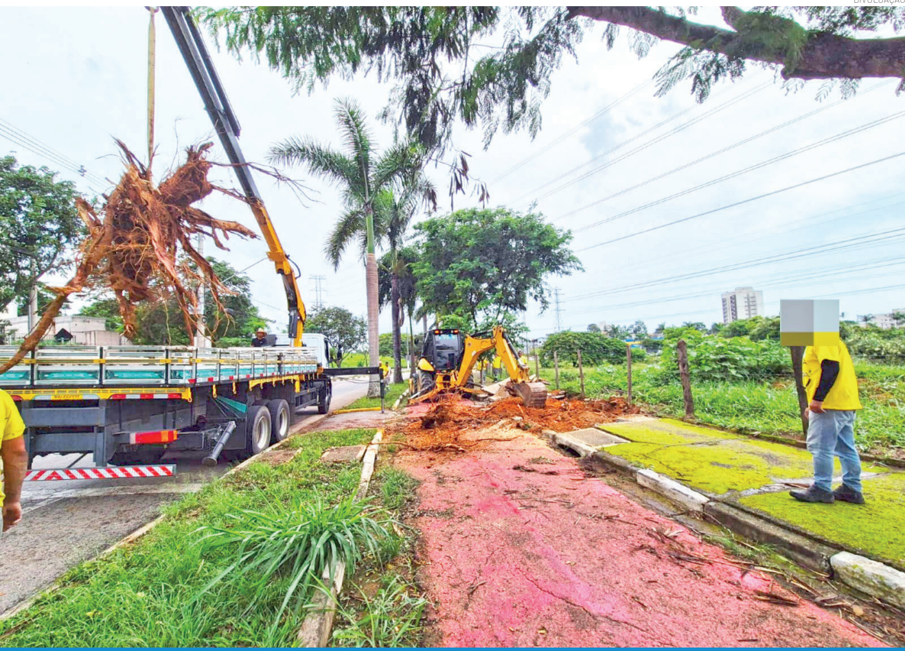
Equipes da Prefeitura reparam calçada e pista de ciclismo afetadas pelos últimos temporais
