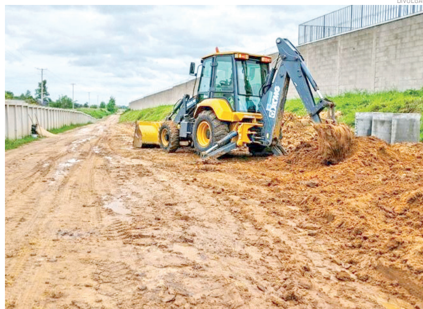
Implantação da galeria de águas pluviais precede a pavimentação
