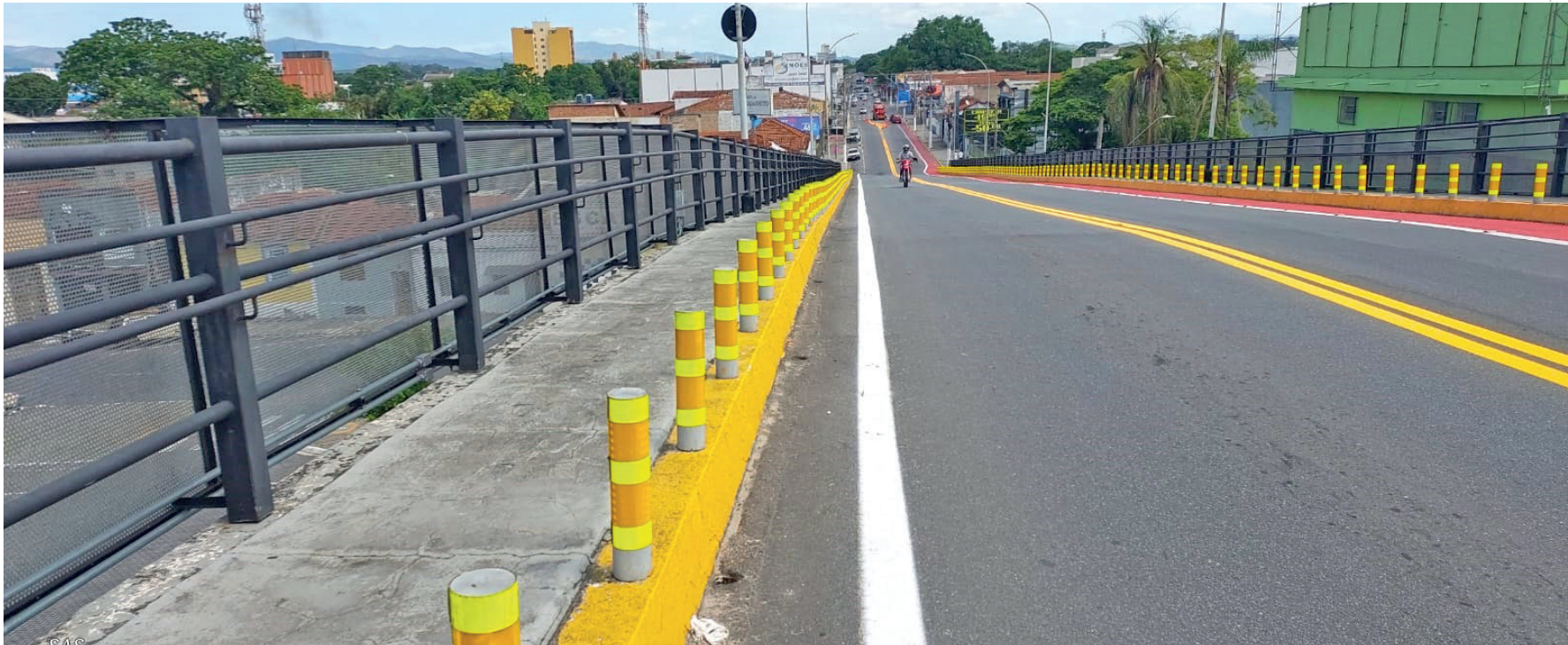
O viaduto João Kozłowski, no centro da cidade, ganhou mais vida com a pintura renovada
