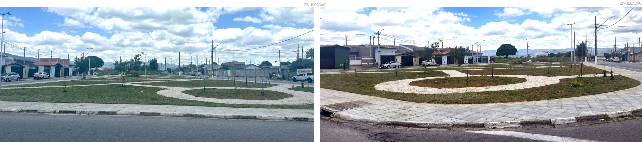
A nova praça transformou a área - anteriormente utilizada para descarte de entulho - em espaço público de convivência com uso adequado
