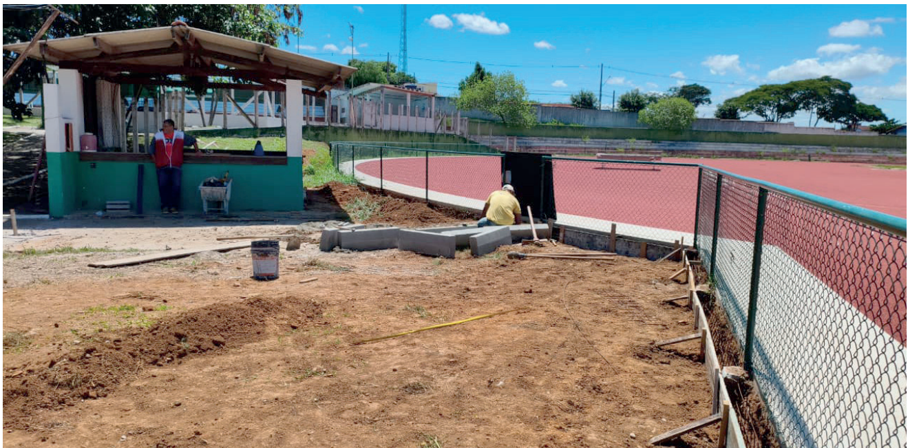
Antes da certificação, a Prefeitura vai concluir a etapa final da pista
