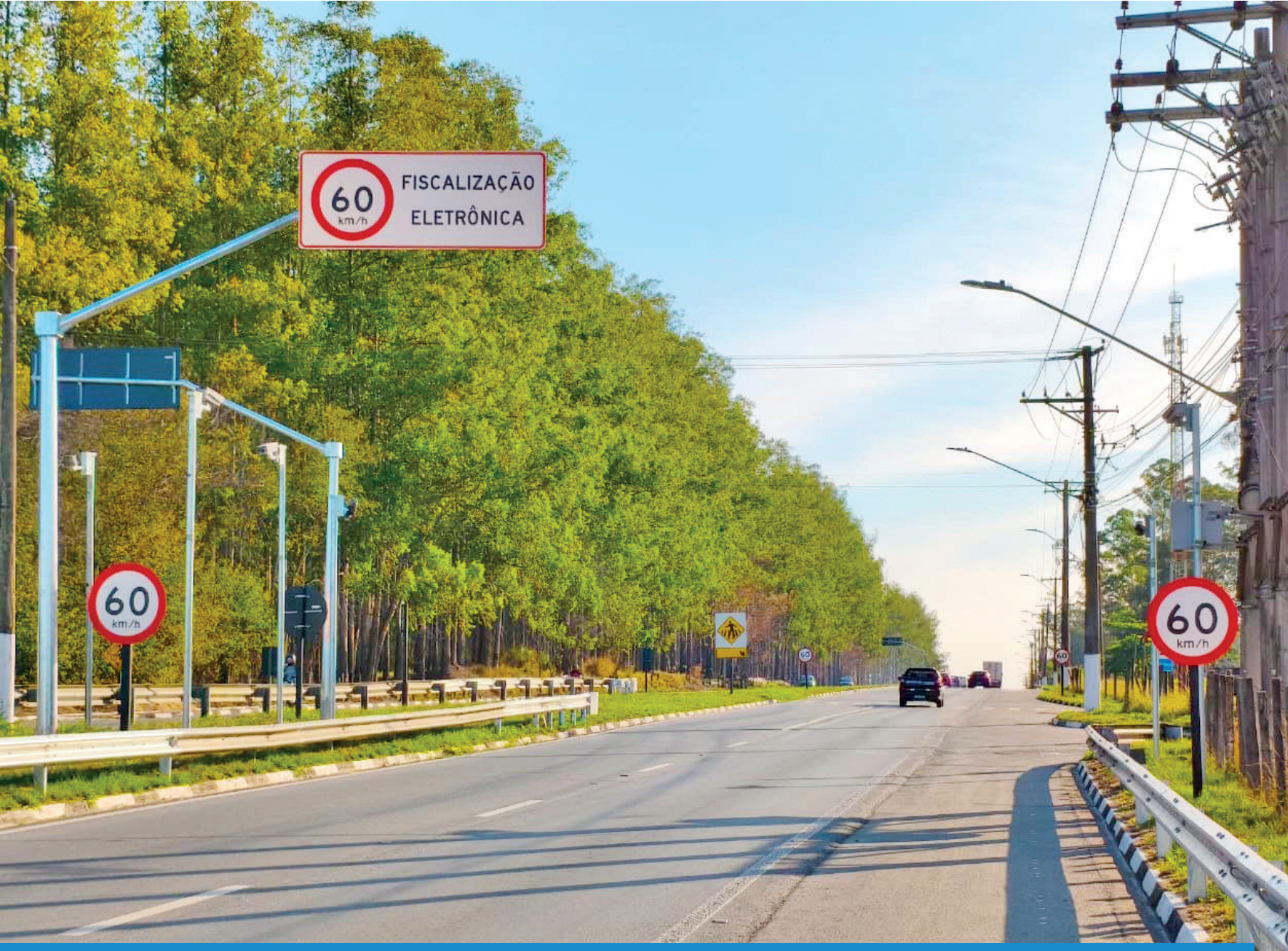
Radar começou a entrar em operação à zero hora de ontem (30) em trecho próximo ao acesso a Coruputuba, com limite de velocidade de 60km/h
