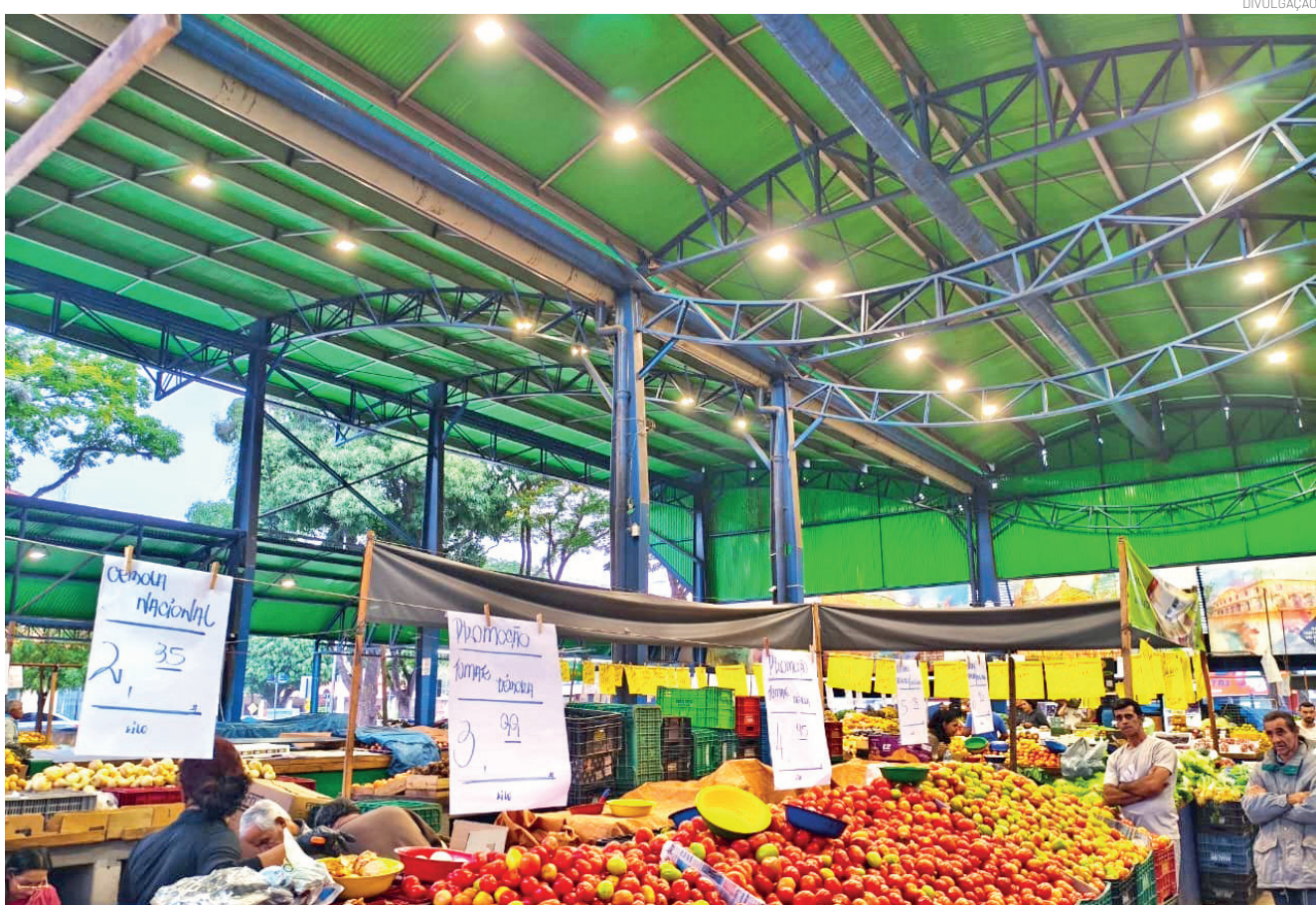
A antiga iluminação foi trocada por lâmpadas de 120 watts LED, além de ganhar novos pontos com luz
