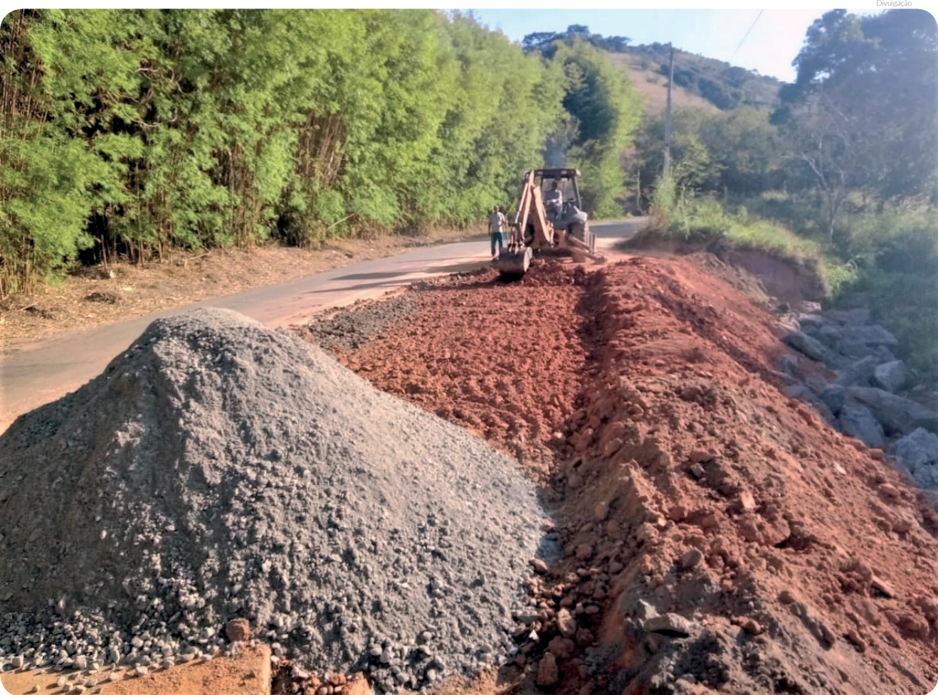
Equipe do Setor de Asfalto iniciou a pavimentação no trecho da estrada nessa terça-feira (29)
