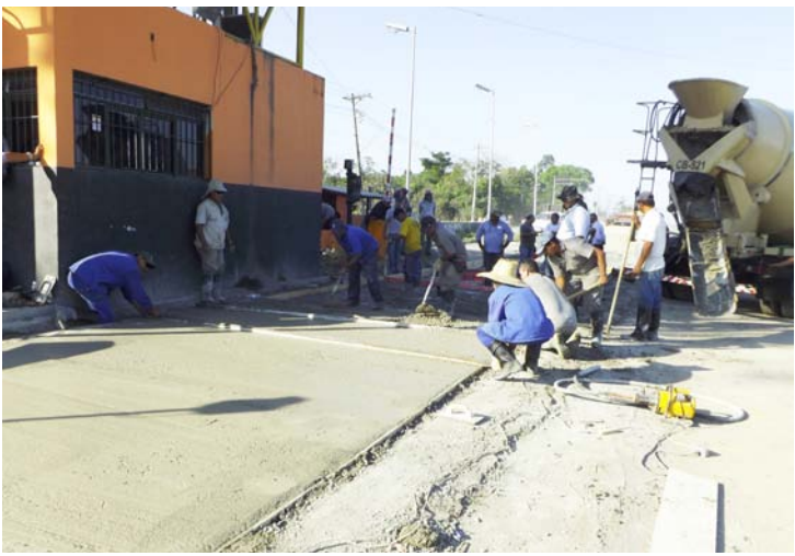
FUNCIONÁRIOS DA PREFEITURA FAZEM A CONCRETAGEM DO PISO NO PEGÁGIO DA SP - 62
