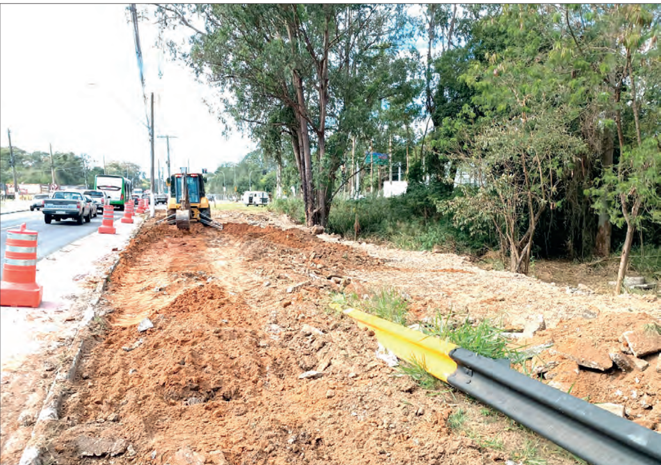
Os trabalhos vão garantir a fluidez do trânsito, evitando congestionamentos no local
