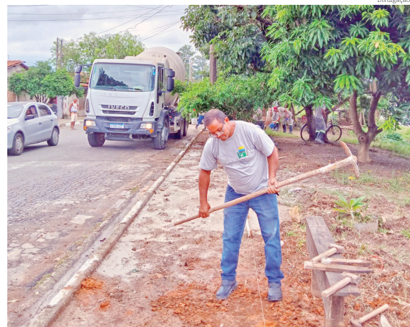
Também estão programadas retirada de lixo e entulho
