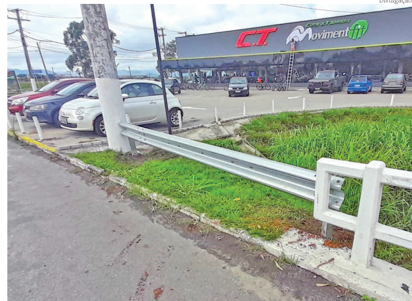
Guard rail foi instalado na ponte do Córrego Barranco Alto
