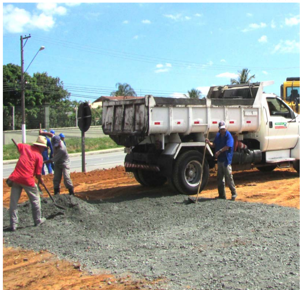
Equipe da Prefeitura durante revitalização do canteiro
