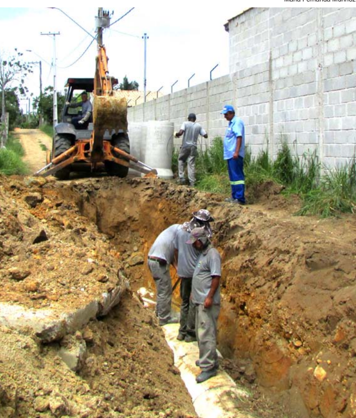
Obras estão em andamento e evitarão enchentes no bairro
