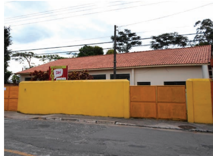
Prédio da escola na Vila São Benedito, que receberá obras de ampliação
