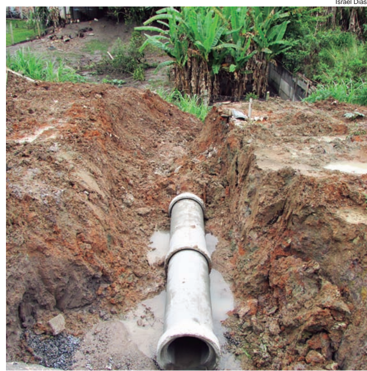
Novos tubos foram instalados para captar água
