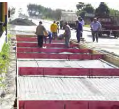
CAIXA PARA RECEBER A CONCRETAGEM NO PEDÁGIO DA SP - 62
