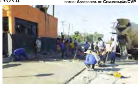
FOTOS: ASSESSORIA DE COMUNICAÇÃO/CVP FUNCIONÁRIOS DA PREFEITURA FAZEM A CONCRETAGEM DO PISO NO PEDÁGIO DA SP - 62
