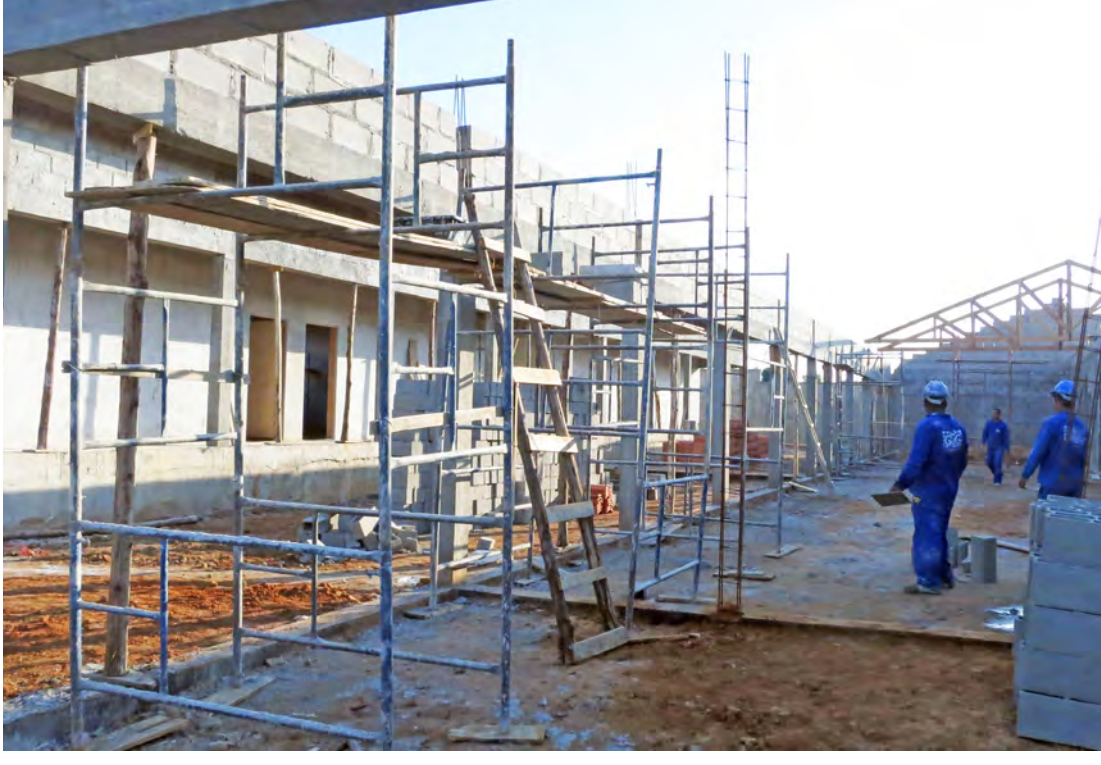
As obras da escola estão adiantadas e a previsão de início das aulas é 2014
