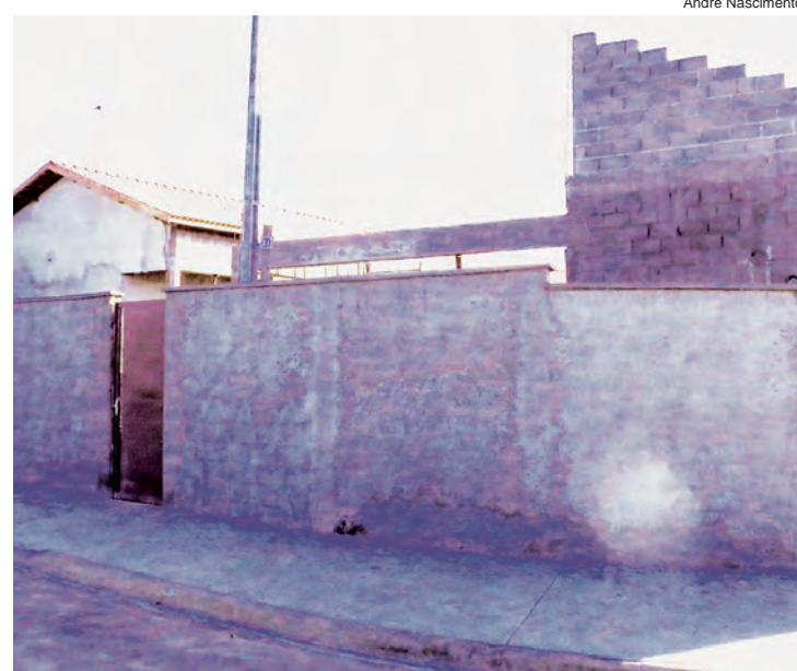
Área externa da escola em fase de construção
