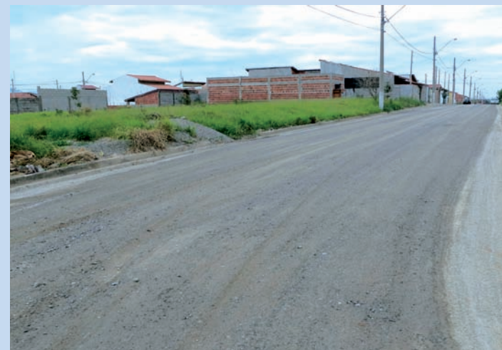
Obras de asfaltamento no bairro
