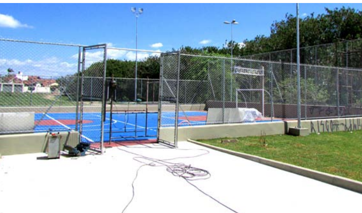
Quadra está em fase final de instalação da iluminação
