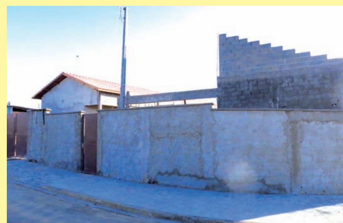
Escola do Morumbi em construção
