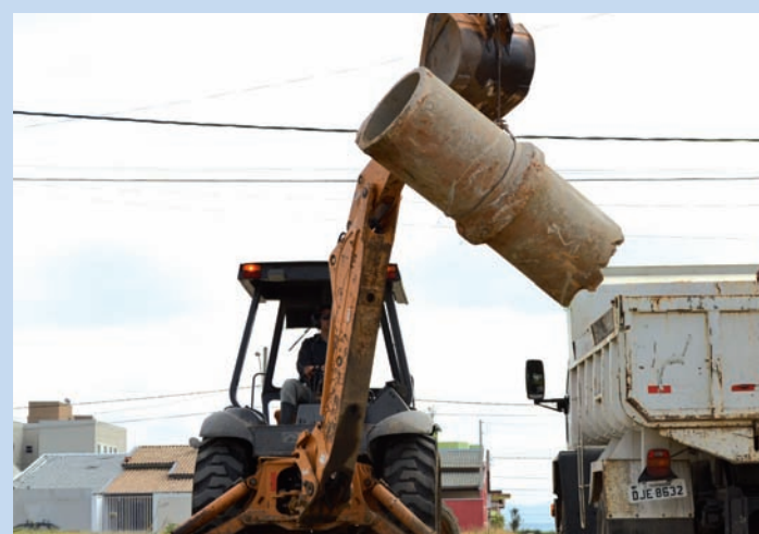
Obras no Parque das Palmeiras
