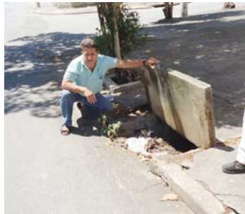
LIMPEZA DAS BOCAS DE LOBO DA RUA GUARATINGUETÁ.
