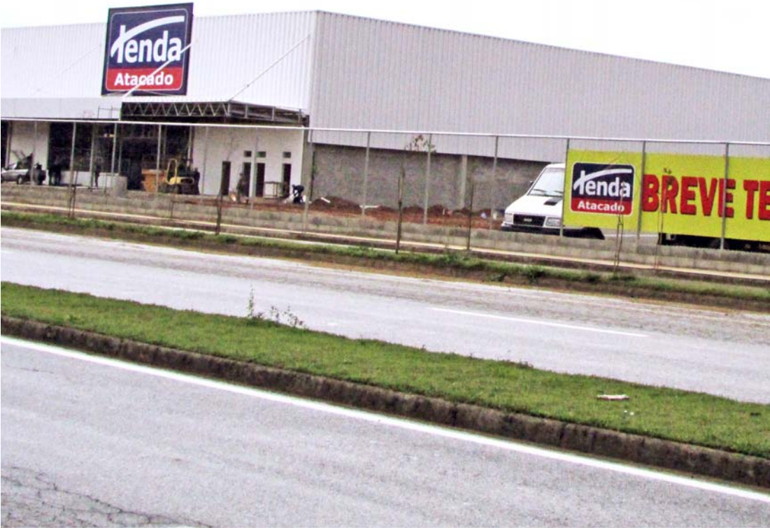
As obras do Tenda Atacado estão sendo finalizadas
