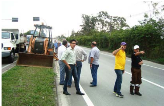
VEREADOR OBSERVA INÍCIO DOS TRABALHOS NO PEDÁGIO DA SP 62
