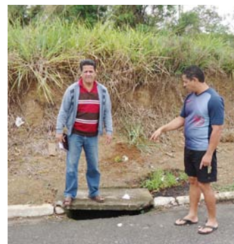
LIMPEZA E REFORMA DE TODAS AS BOCAS DE LOBO NA RUA CASTRO ALVES (AO LADO DO RIBEIRÃO)
