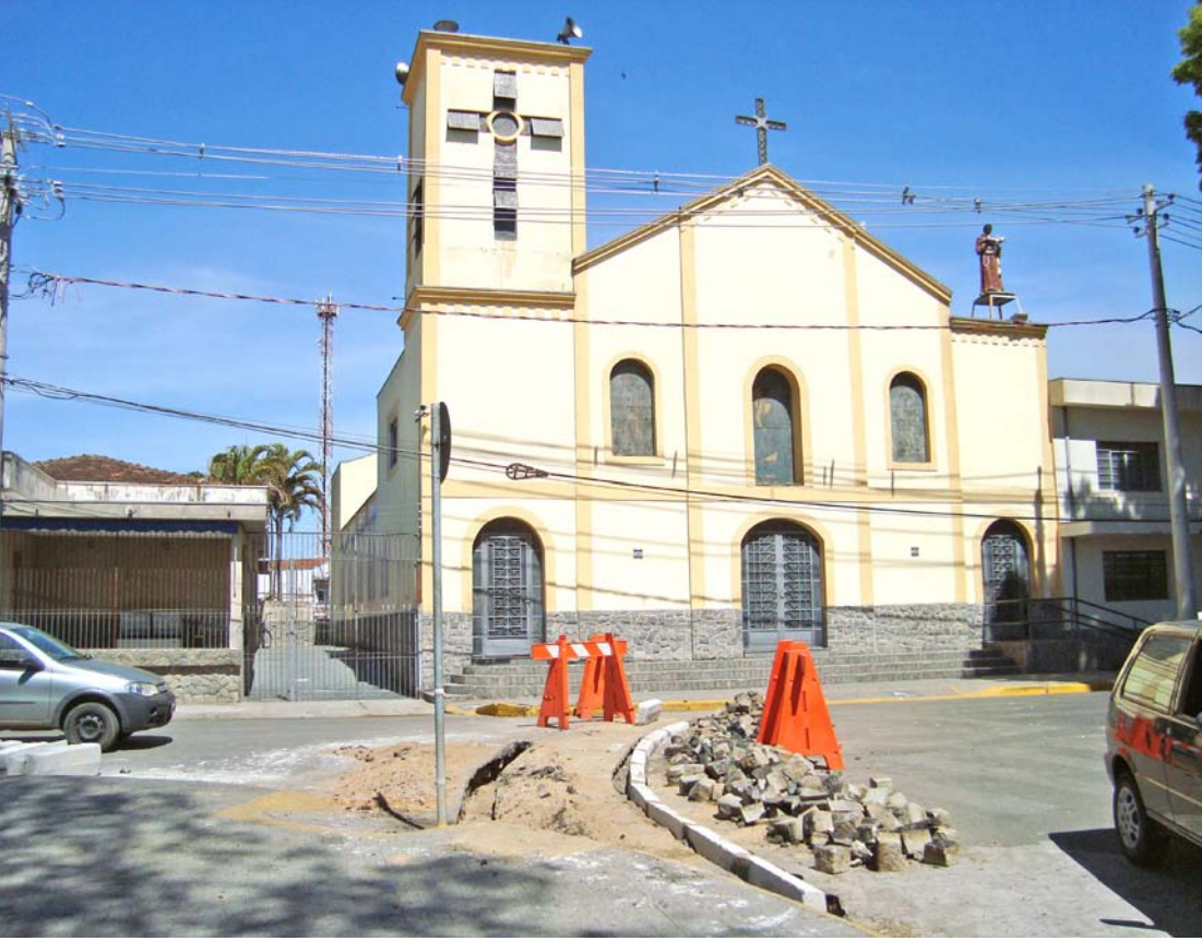
As obras para fechamento da rua já foram iniciadas e levarão fluidez ao tráfego
