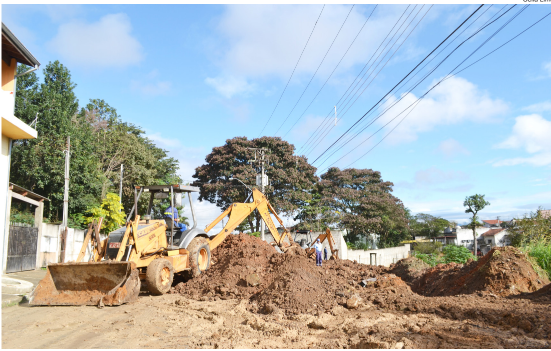
O eixo principal do novo coletor está localizado na rua Simão Dênis
