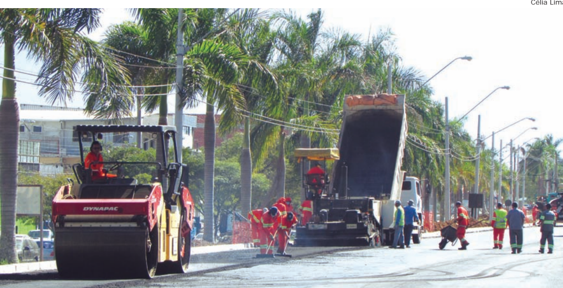
Obra da duplicação na avenida NS do Bom Sucesso será entregue em outubro
