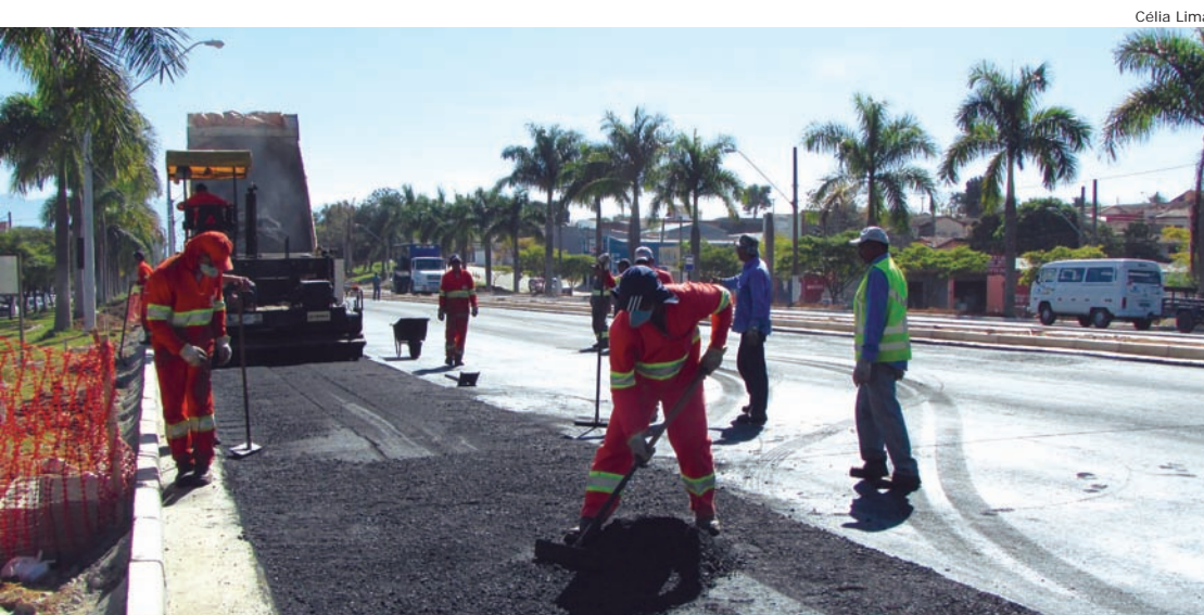
Funcionários finalizam pavimentação nas imediações do bairro Ouro Verde
