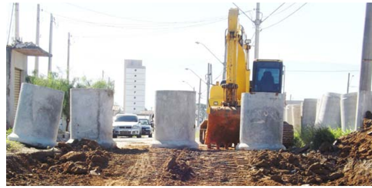
GALERIA DE ÁGUAS PLUVIAIS NO LOTEAMENTO PARQUE DAS PALMEIRAS
